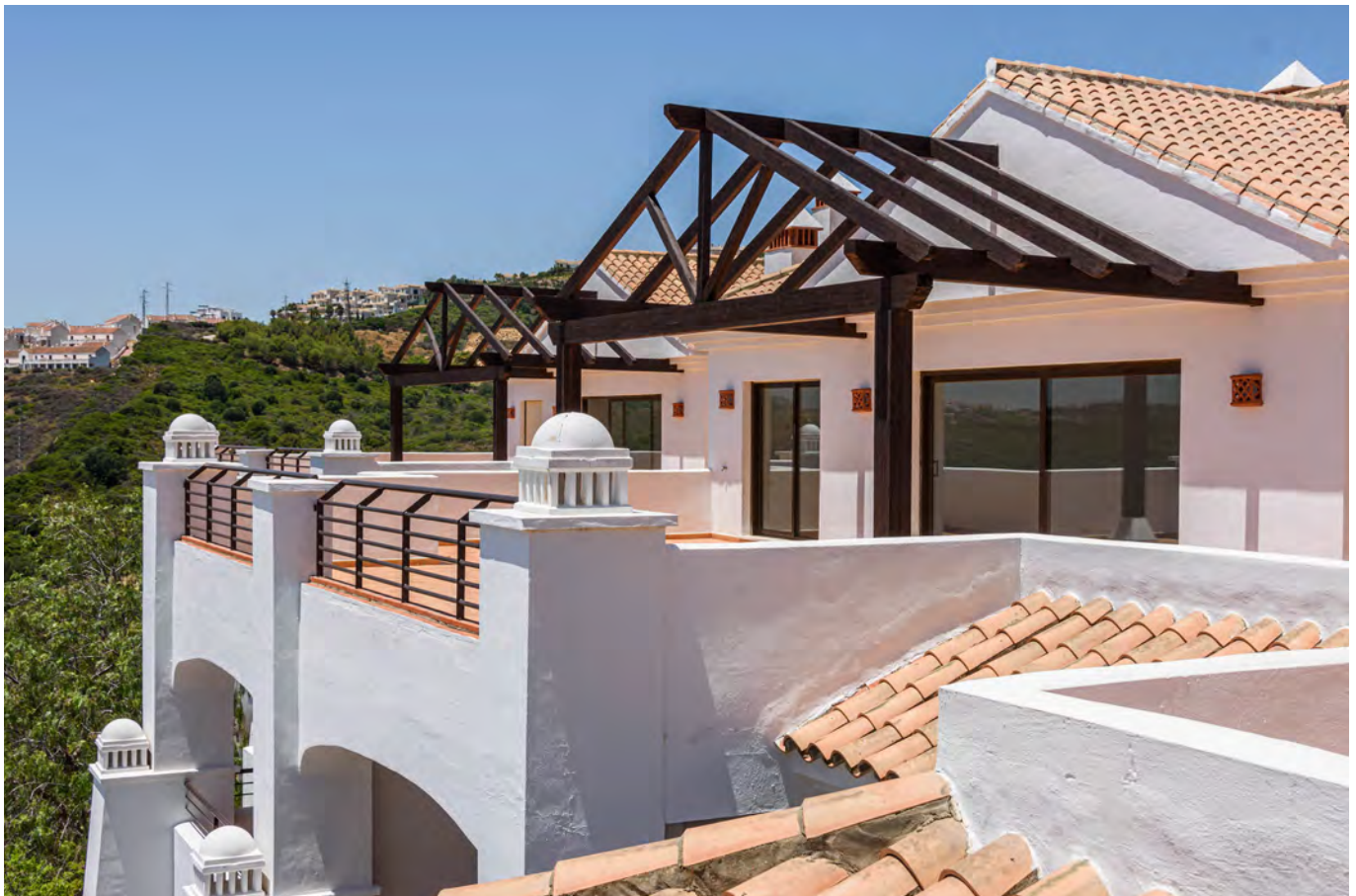
Foto: Vivienda propiedad de Árqura Homes en Casares, Málaga
