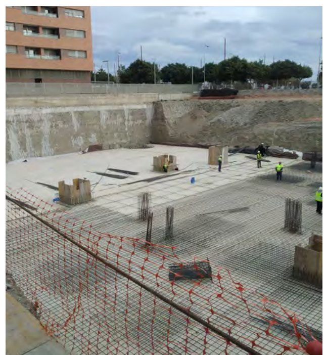
Foto: Obras en curso de una promoción de Árkura Homes en Almería (Andalucía).
