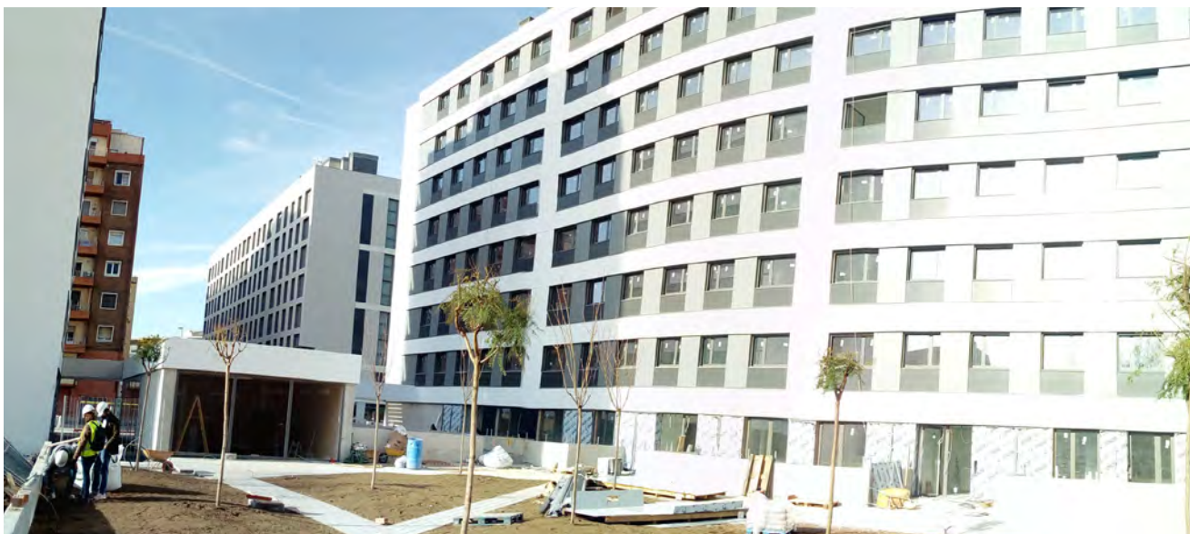
Foto: Edificio residencial de Àrquera Homes en Barcelona (Cataluña).
